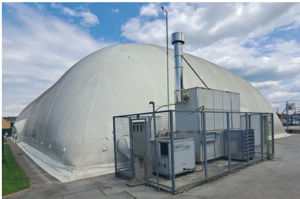
Slika 4.2: Obstoječa presostatična dvorana
